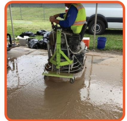
**El proceso de pulido húmedo ofrece numerosos beneficios de seguridad y eficiencia:** Reduce el desgaste del equipo, logra un alto brillo del piso, previene el fundido de las herramientas y minimiza las picaduras en la superficie del concreto. ¡Ideal para principiantes!
